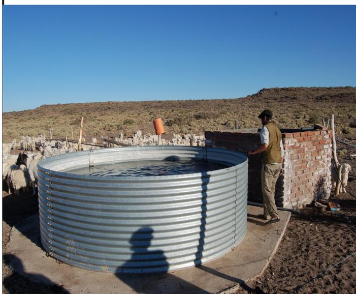
Pozzo con serbatoio di raccolta acqua con pompaggio
